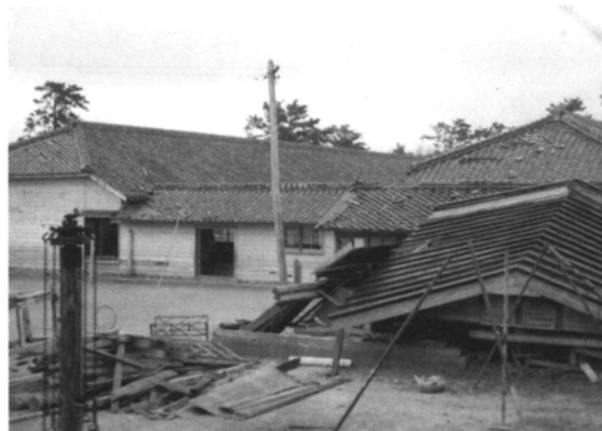
昭和34年 伊勢湾台風で被災した高根小学校
