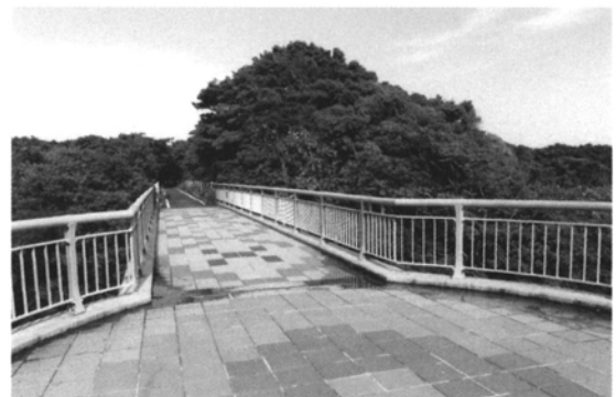
自転車道（高塚町地内より）
