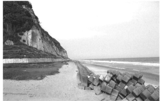
平成18年 海蝕崖と消波堤
