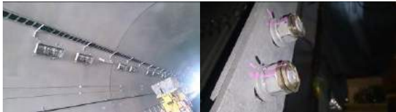
< 高速道路トンネル照明取付け工事 >
