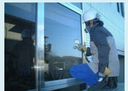
＜スプレーガンによる吹きつけ＞
