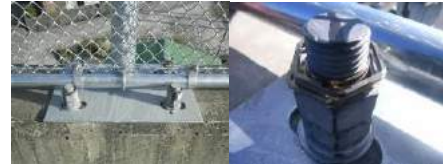
< 高速道路安全柵取付け工事 >
