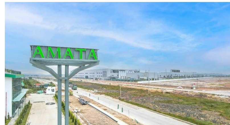
工業団地オフィス付近
