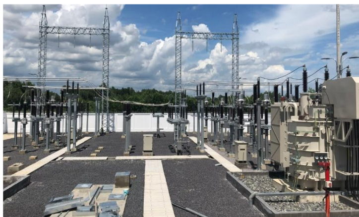
自社 変電設備 (110/22kV) 容量 126MW (第1期 63MW) 22KV供給線にて電力供給 (2022年建設完了)
