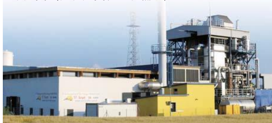
木材ガス化プラント
