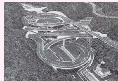
▲国道 2 号三原バイパス恵下谷ランプ
