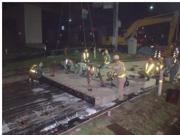
④プレキャスト舗装版施工状況
