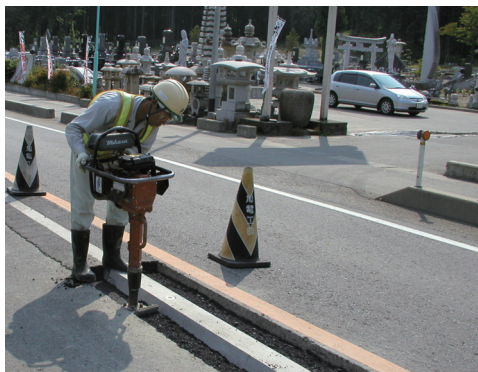
②消雪パイプの施工状況(プレキャスト)
