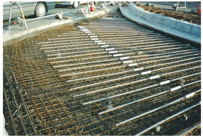
①ヒートパイプ設置状況
