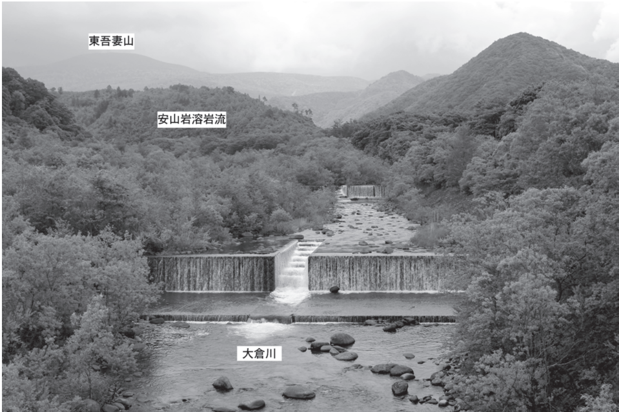
第 7.3 図 新大倉川橋から見た東吾妻山火山噴出物の安山岩溶岩流 東吾妻山(1,975.1m)から大倉川を流れ下った溶岩流は、本地域内の標高 850 m 地点に到達している。旧大倉川橋は、1989 年 8 月上旬の台風 13 号豪雨に伴う土石流で流失している。新橋は災害後の河川改修時に掛け替えられたもので、大倉川の河床にも砂防工事が施されている。福島県猪苗代町西高森(北緯 37 度 39 分 16.3 秒, 東経 140 度 11 分 23.0 秒)。
