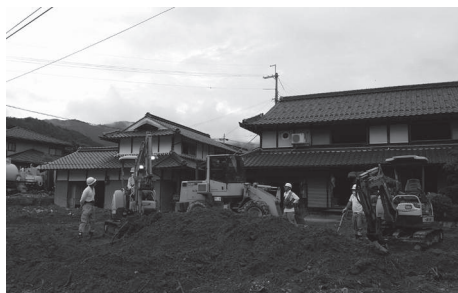
土砂の撤去作業（丹波市内）
