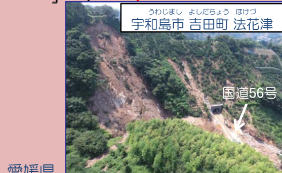
愛媛県 林地荒廃 249か所 治山施設 2か所
