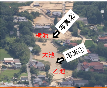
被災状況 広島県 乙池・大池・横池(重ね池)
