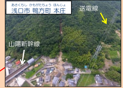
岡山県 林地荒廃 125か所
