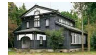
ゆるく傾斜した外壁、中央にそそりたつ塔。南阿蘇の丘の上に立つ、阿蘇の火山・地震活動を研究する施設だ。阿蘇の山の形をモチーフにした台形の扉や窓、細部まで装飾の施された螺旋階段、斜めにくり抜いた壁、個性的な暖炉の数々と、凝った意匠が随所に施されている。2016年の熊本地震では、大きな地滑りと揺れで建物の基礎と内部を激しく損傷。解体の話もあったなか、施設関係者は復旧の道を選んだ。基礎を補強のうえ沈下した建物をジャッキアップし、内部は可能な限り補修・復元。大規模な仕事を経て戦前に建てられた建築が再び命を宿し、未来へつながれた。今後は震災教訓の発信にも力を入れるという。国の登録有形文化財、日本におけるDOCOMOMO選
