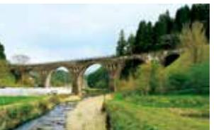
「旧国鉄宮原線幸野川橋梁」は旧肥後小国駅と旧北里駅の間にある6連アーチ橋で、1939（昭和14）年ごろにつくられた。中央の4連は径間20mの大規模アーチとし、その両脇に径間10mのアーチを連続させている。また、アーチ間の壁に小アーチによる「透かし」のようなデザインも施されている。当時は鉄不足だったことからコンクリートの中に鉄筋に竹を入れたと伝えられ、「竹筋橋」ともいわれる。登録有形文化財
