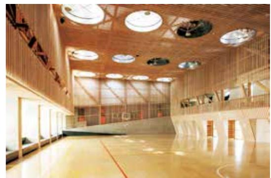
くまとアートボリス事業の1つとして、地域住民とのワークショップを経て計画された体育館。外壁のステンレス板に対して、内部には地元の杉材のルーバーを使った温かみのある空間が広がる。アリーナの大空間に屋根を架けるために巨大なボックスストラス構造を採用し、そのトラス空間を自然光を導く高窓として利用している。凸状に屋根が盛り上がっている部分だ。取り入れた光は、光ダクトによって室内へと届けている。現在は、小学校の統廃合により閉校し、施設は町の体育施設として住民に開放されている
