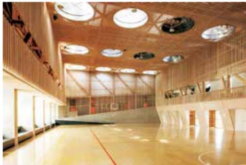
くまもとアートポリス事業の1つとして、地域住民とのワークショップを経て計画された体育館。外壁のステンレス板に対して、内部には地元産の杉材のルーバーを使った温かみのある空間が広がる。アリーナの大空間に屋根を架けるために巨大なボックストラス構造を採用し、そのトラス空間を自然光を導く高窓として利用している。凸状に屋根が盛り上がっている部分だ。取り入れた光は、光ダクトによって室内へと届けている。現在は、小学校の統廃合により閉校し、施設は町の体育施設として住民に開放されている
