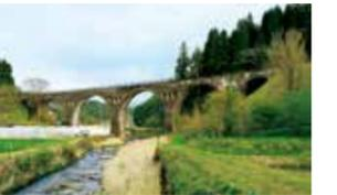
「旧国鉄宮原線幸野川橋梁」は旧肥後小国駅と旧北里駅の間に6連アーチ橋で、1939(昭和14)年ごろにつくられた。中央の4連は径間長20mの大規模アーチとし、その両脇に径間長10mのアーチを連続させている。また、アーチ間の壁に小アーチによる「透かし」のようなデザインも施されている。当時は鉄不足だったことからコンクリートの中に鉄筋の代わりに竹を入れたと伝えられ、「竹筋橋」ともいわれる。登録有形文化財
