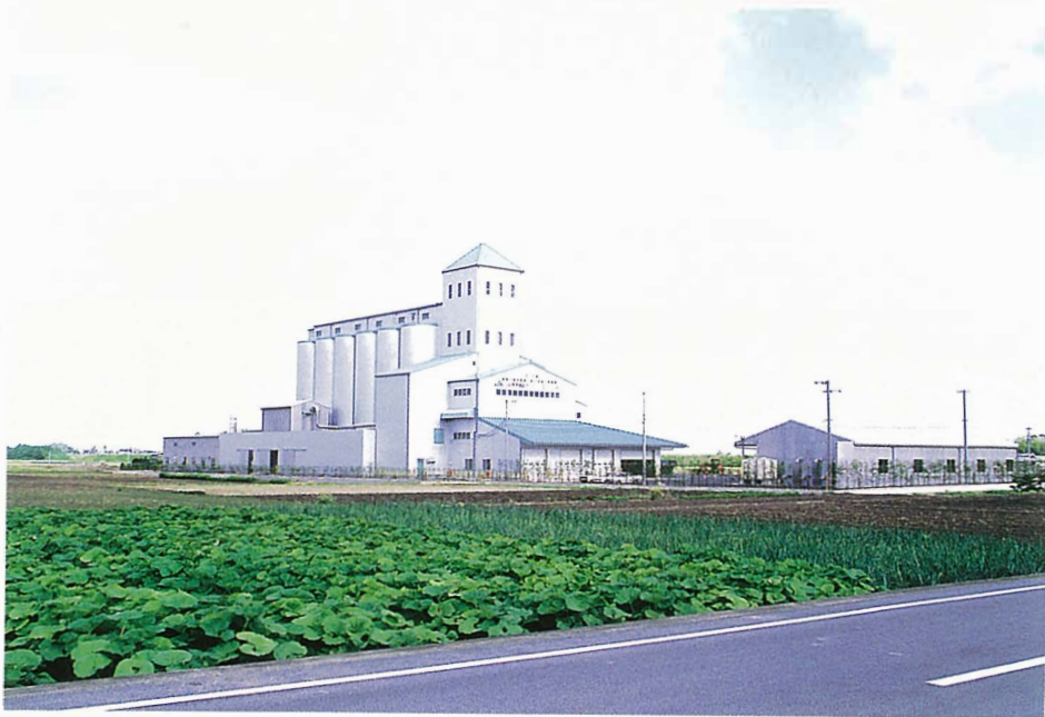
発掘後の伊予地区カントリーエレベーター
