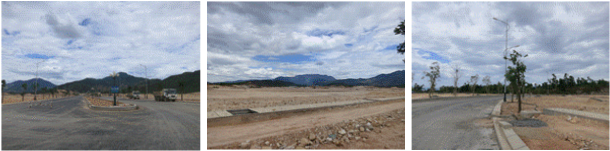
図 2-15 建設中のダナンハイテクパーク（右の写真は国道 1 号線へのアクセス道路）
