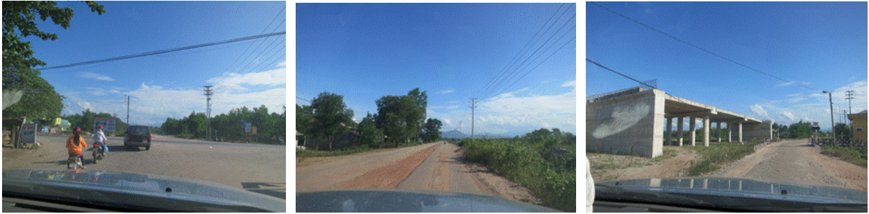
図 2-25 国道 1 号線からフォンディエン工業団地へのアクセス道路(左:国道 1 号線との交差点)、(中:整備が必要なアクセス道路)、(右:建設中の鉄道越え陸橋)
