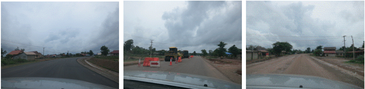
図 2-35 ラオス国内の東西経済回廊における改良済区間（左）、改良工事中区間（中・右）
