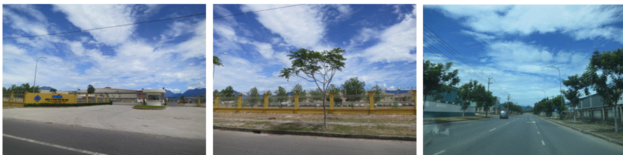
図 2-13 拡大ホアカン工業団地の自動車組立工場（左及び中）、同団地内の道路（右）
