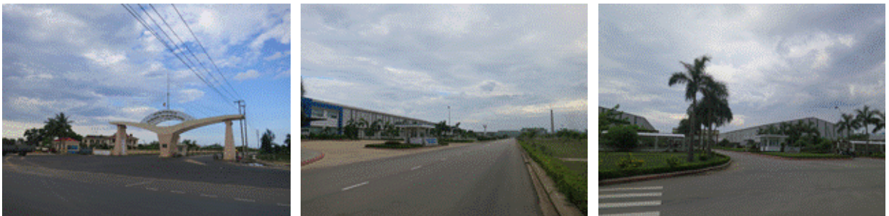
図 2-18 チューライ経済開放区の入口（左）、自動車組立工場および化学プラント（中）、別の自動車組立工場（右）
