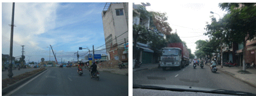
図 2-12 ティエンサターミナルとホアカン工業団地を結ぶ国道 1 号沿いの陸橋建設現場（左）、トレーラーが市内で迂回路を通行する状況（右）
