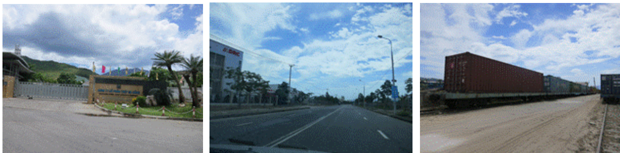
図 2-14 リエンチュウ工業団地の工場（左）、付近のアクセス道路（中）、団地内の鉄道ヤード（右）
