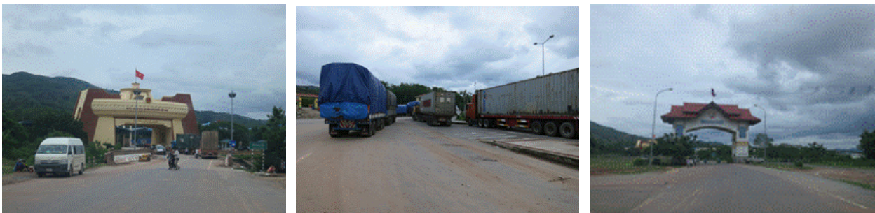
図 2-37 ベトナム・ラオス国境（ベトナム側：ラオバオ（左・中）、ラオス側：デーンサワン（右）） 中央の写真のブルーシートで覆われたトレーラは丸太を輸送している
