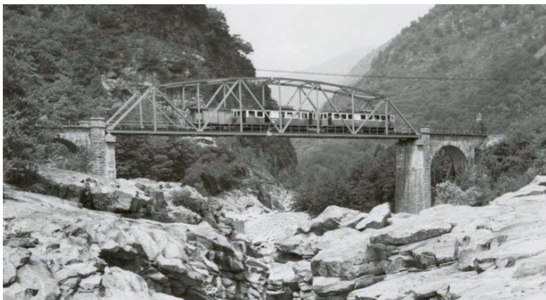
Abb. 17: Brücke in Ponte Brolla; heute Fussgängerbrücke (Quelle: http://www.valmaggina.ch/i_4-5.html )
