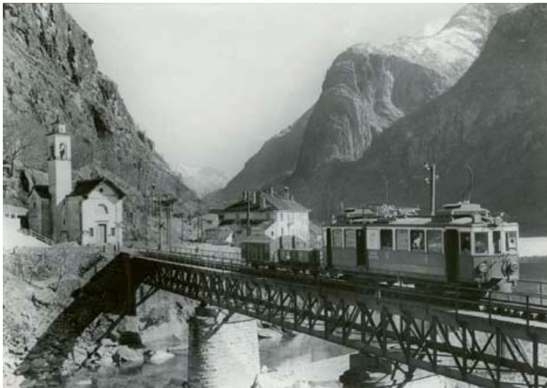
Abb. 16: Alte Brücke von Cevio, existiert noch (Quelle: http://www.valmaggina.ch/i_4-5.html )
