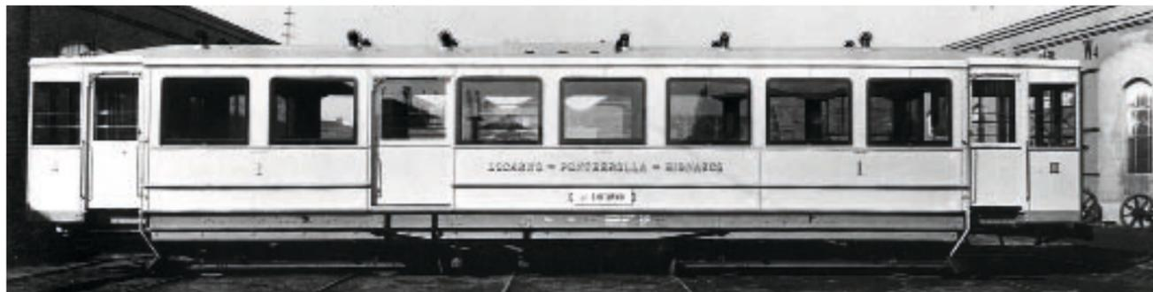
Der Wagenkasten des Motorwagens Nr. 1 noch vor dem Einbau der elektrischen Ausrüstung.
