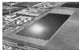
中国電力様 福山発電所(3MW)
