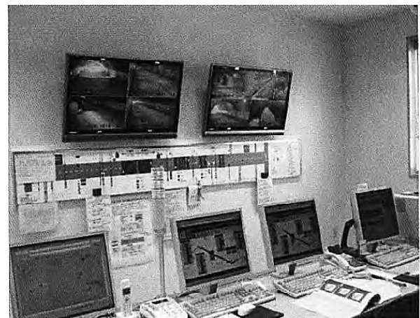
写真2 甲子道路管理所
