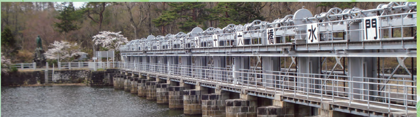
十六橋水門（会津若松市・猪苗代町）〔土木学会選奨土木遺産〕
