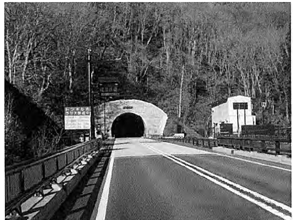
写真1 甲子トンネル西郷側坑口
