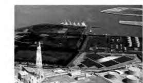
東北電力様 八戸発電所(1.5MW)
