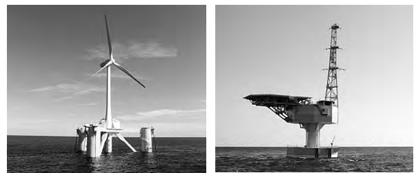
図9 2 MWダウンウインド型浮体式洋上発電設備
