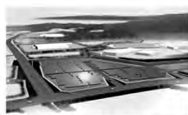
北陸電力様 志賀発電所(1MW)
