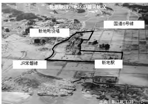
写真-1 新地駅周辺地区の被災状況
