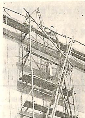
第 3 圖 船側外板溶接部の X 線撮影状況
