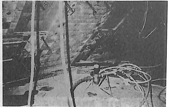
第5図 接着作業用治具
