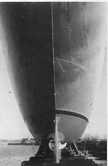
(下) 進水直前の本船、ポンツーンに乗せられたまま横滑り方式で進水
