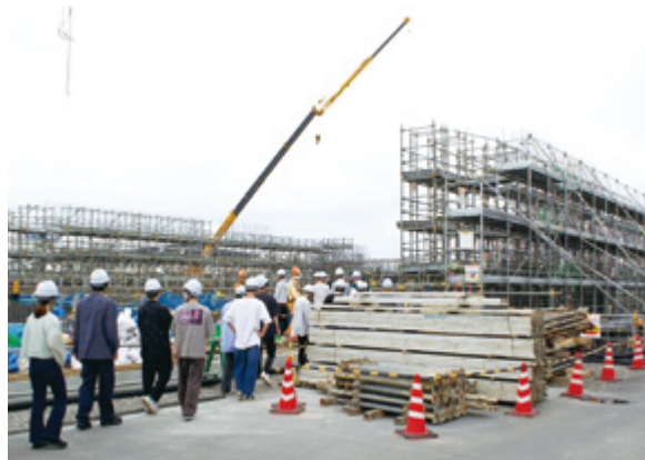
建設工事現場の見学
