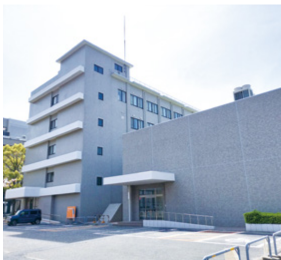
改修工事で新しくなった知能情報北棟と南棟
