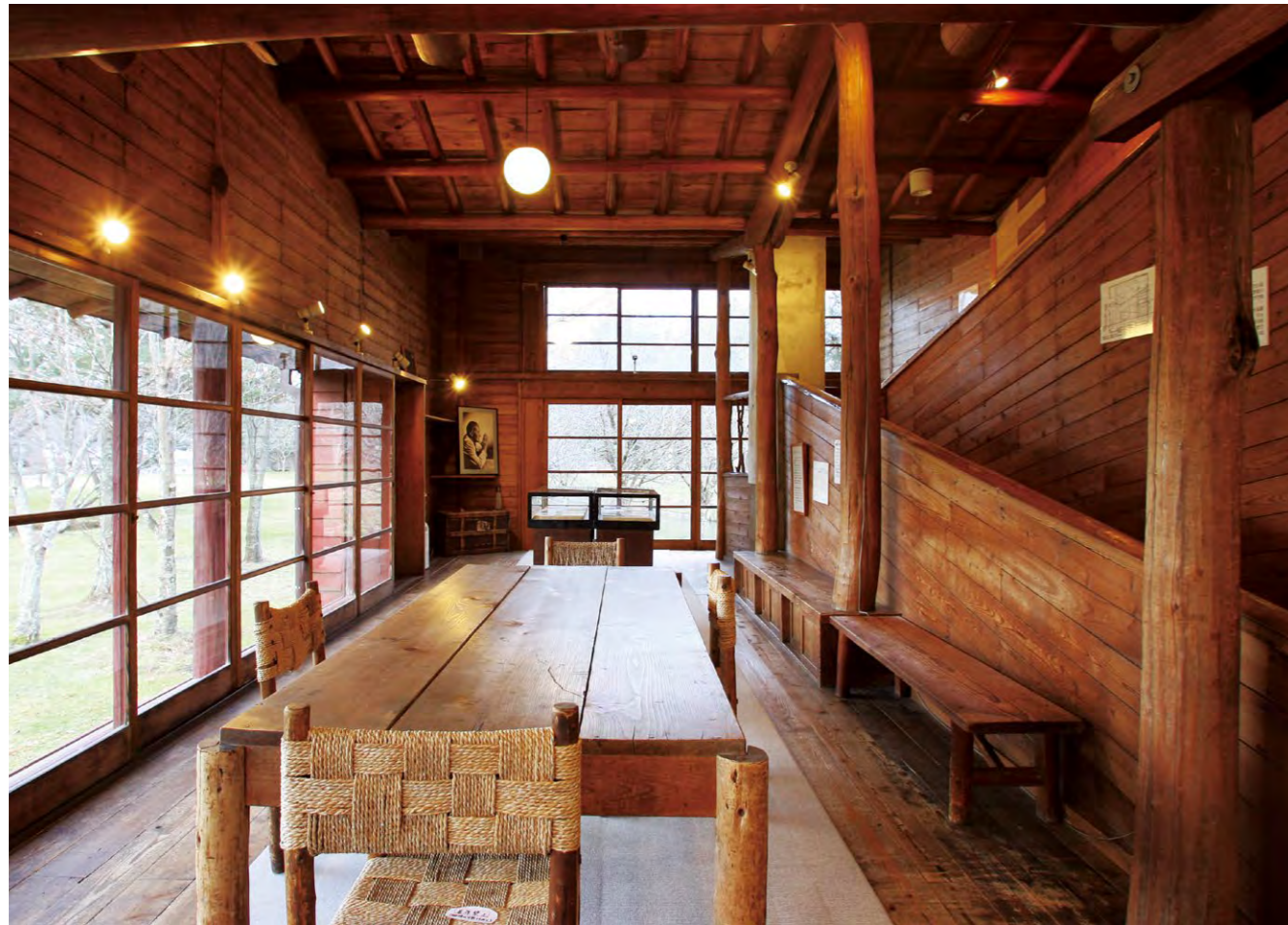
ダイナミックにスロープを配した夏を家の居間。窓を開放すれば自然との一体感が生まれる。柱を数居の位置から外へずらす「芯外し」の手法も開放感を高めている。
