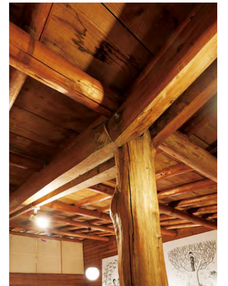
V字を描き、野趣あふれる居間天井。梁や丸太柱を現しにした点にも日本的なニュアンスが感じられる。
