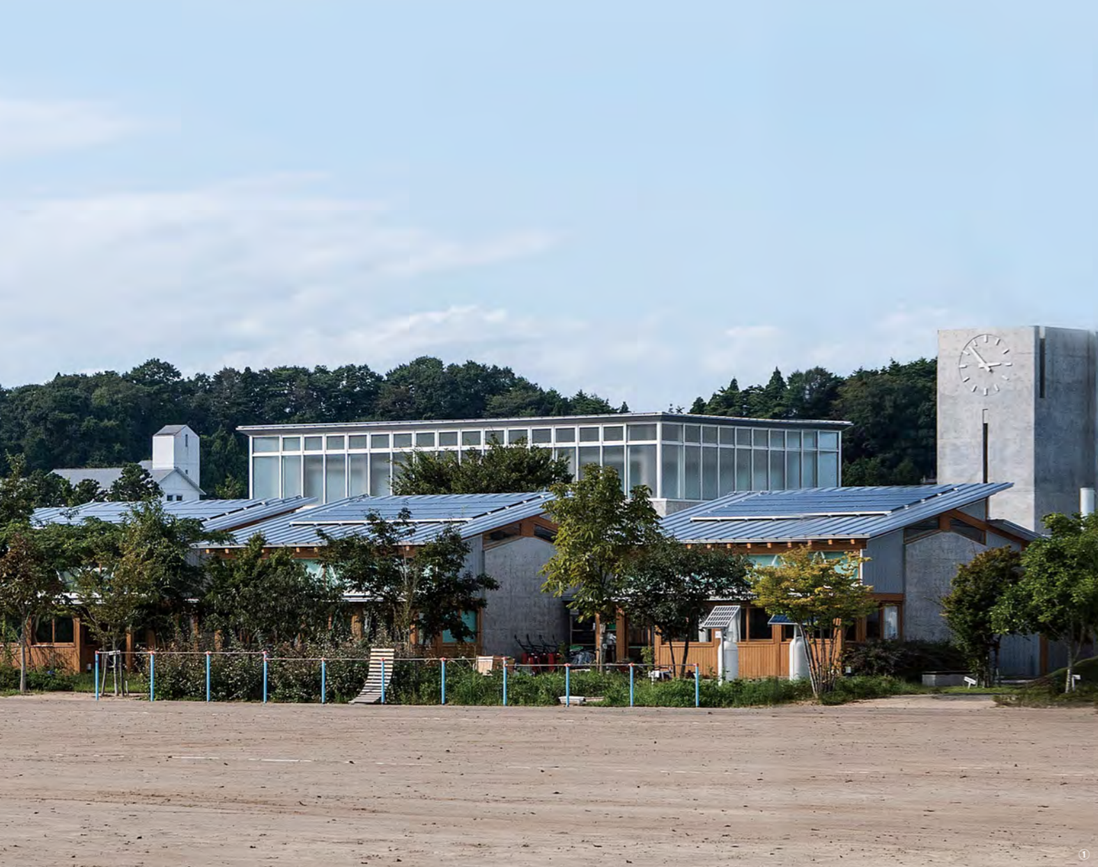
①各学年の教室がある教育棟の屋上に設置された太陽電池モジュール
