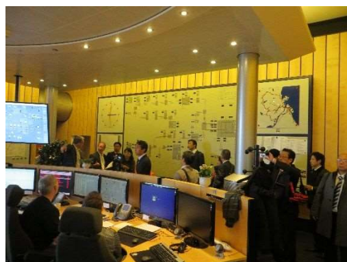
コントロールタワーの視察の様子
