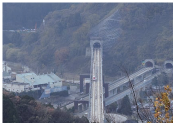
写真-6 北陸道架道橋
