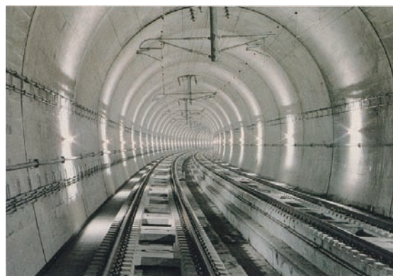
写真-1 五里ヶ峯トンネル
