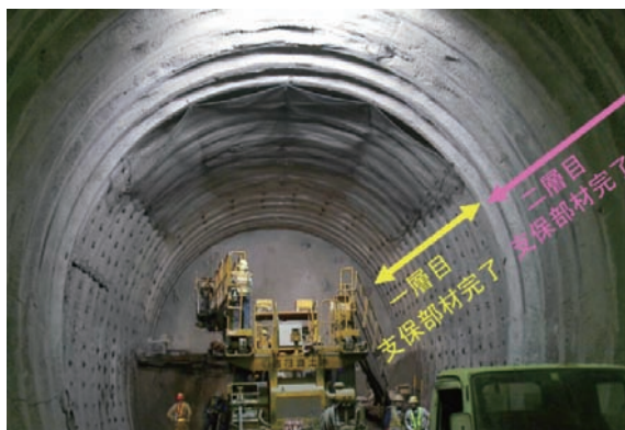
写真-4 多重支保工法（飯山トンネル）
