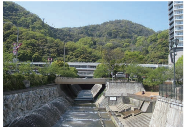
写真1 新神戸駅外観（南口遠方より撮影）
