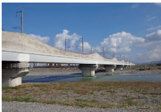
写真-5 姫川橋りょう
