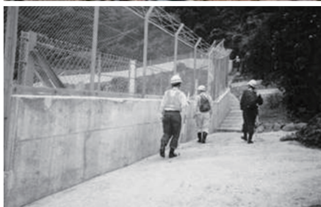
図 2 斜面对策 (a) フリーフレーム工 (b) 土砂留工（切土） (c) 土砂留工（トンネル坑口）
