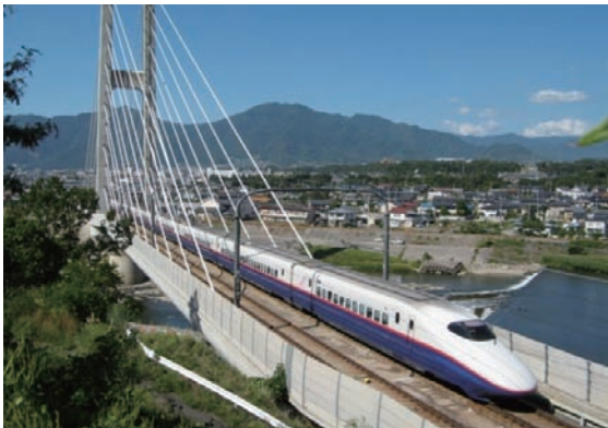
写真-2 第2千曲川橋りょう
