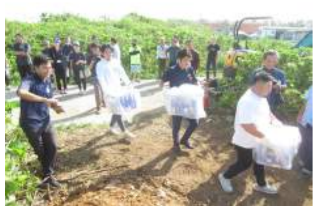
次の10年に向けて埋設作業
