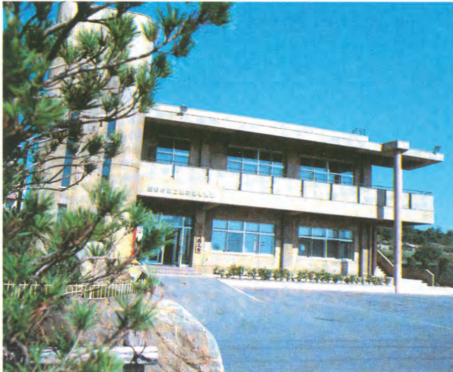
商工会館全景
