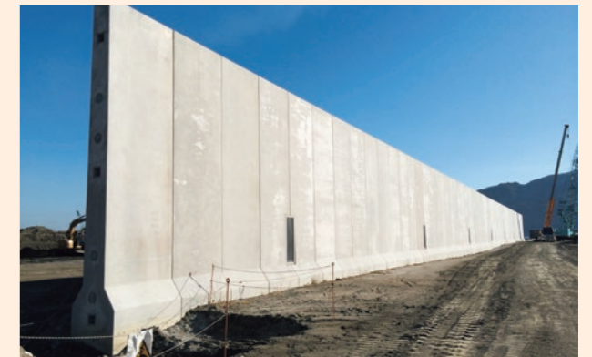
プレキャスト防潮堤
