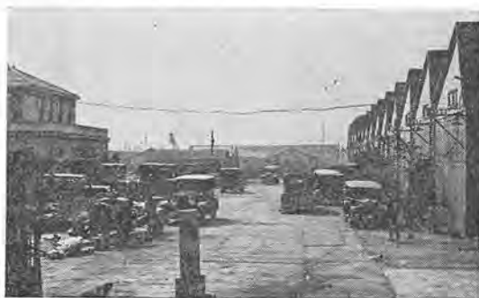
当時の芝浦工場。中央左手に荷揚げ用クレーン
