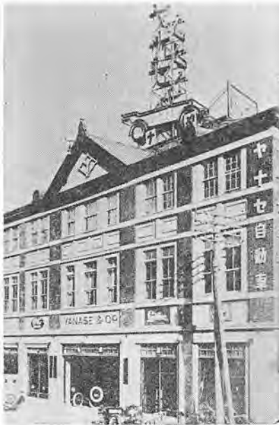
大正6年当時の呉服橋本社。屋上に自動車の形をした広告塔
