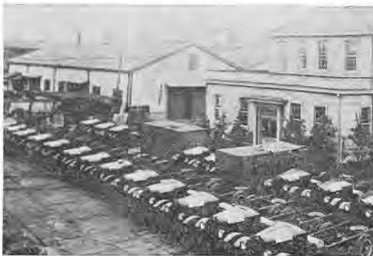
昭和3年当時の陸揚げされたレオ・トラック
