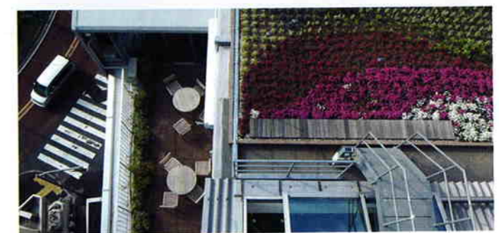
ヒートアイランド対策の実験の場（60kg/m 2 の超軽量化）
