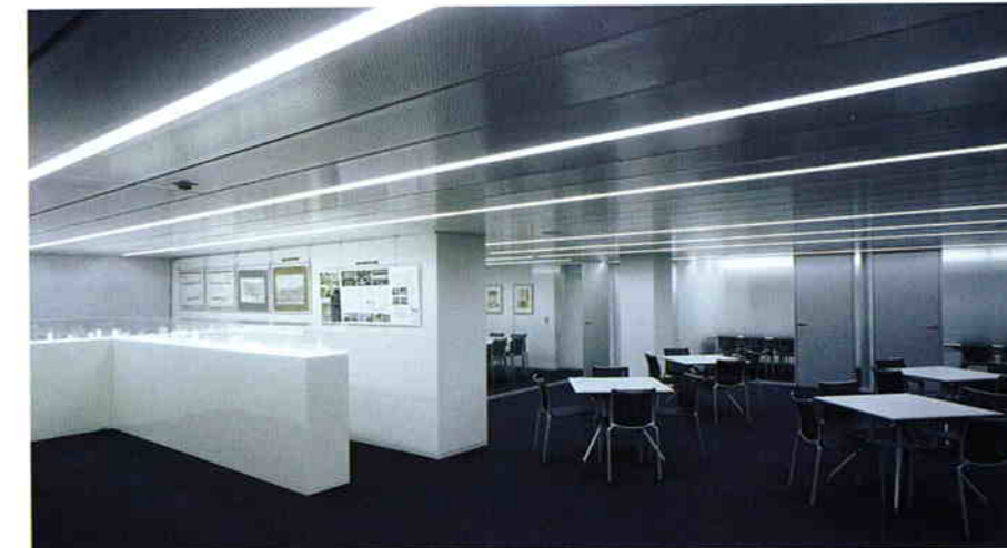
1階ロビー（天井放射冷暖房システム）
