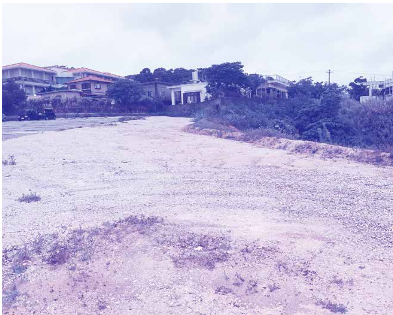
ユンタンザミュージアム南側駐車場整備
