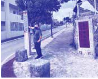
座喜味公民館前の錆びた街灯
