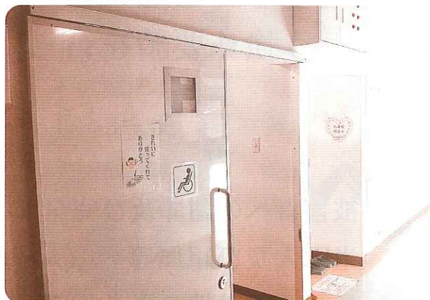
改修によって快適になった古堅小学校トイレ
