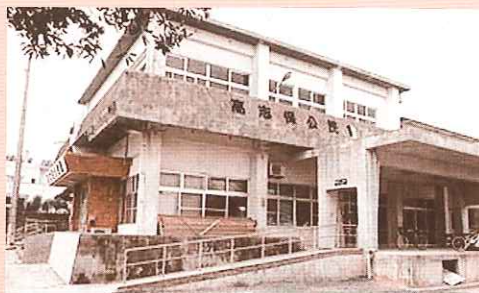
耐震診断の必要な公共施設(高志保公民館)
