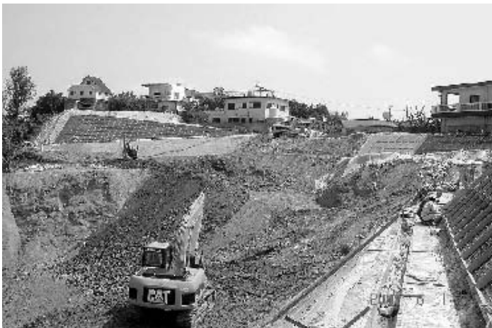
▲補強筋工法による斜面对策工事
