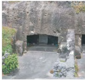
⑦ 彫り込み墓 ※柔らかな凝灰岩地質を利用した粟国独特の墓です。
