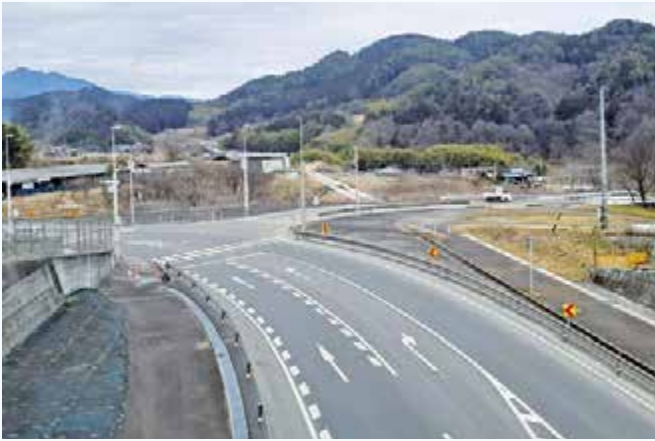
「山本インターから眺む」直進にトンネルが掘られます
