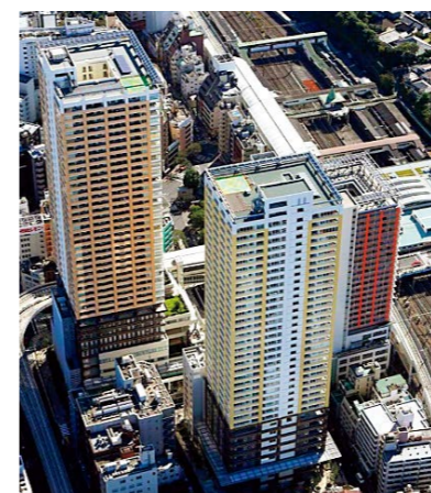
駅前区画整理地区の再開発 ひぐらしの里北 【荒川区 0.4ha】(H21.10完了)
