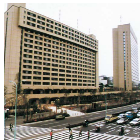
公共水面である飯田濠を 暗渠化し、交通結節拠点を整備 飯田橋 【千代田区・新宿区 2.3ha】(S59.3完了)
