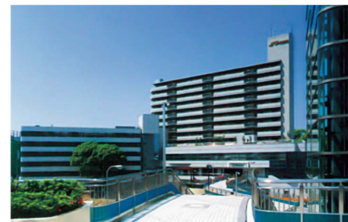
シンボルゾーンとしての駅広整備 河内長野駅前 【河内長野市 1.8ha】(H1.5完了)
