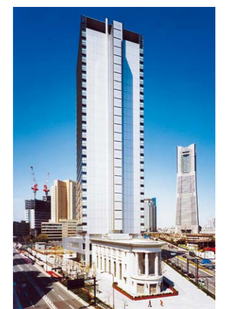
歴史的建造物を移築して保存・修復 北仲通南(第一工区) 【横浜市 3.0ha】(H15.2完了)
