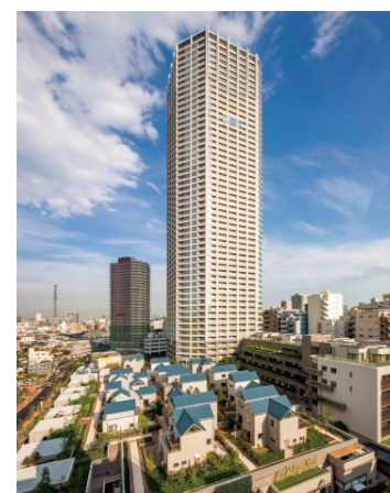
バブル後の悪化した住環境の解消・都市型住宅や生活支援施設を整備 西富久 【新宿区 2.6ha】(H27.9完了)
