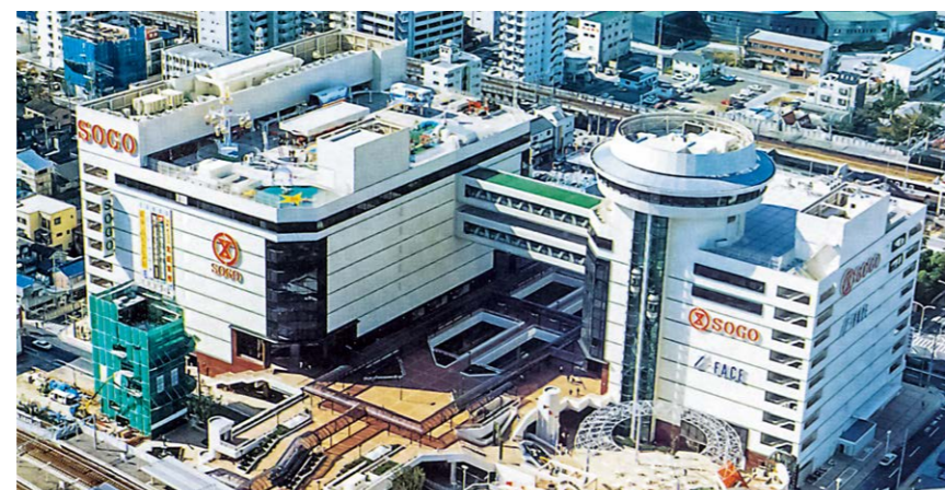
ペDESTリアンデッキ導入による 総合的駅エリア整備事業 豊田市駅西口 【豊田市 1.8ha】(S63.10完了)
