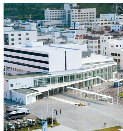
駅と一体的に交通・情報・交流・にぎわいの拠点を整備
