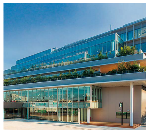
ホールや図書館等の公益施設中心の整備 大和駅東側第4 【大和市 1.2ha】(H28.7完了)
