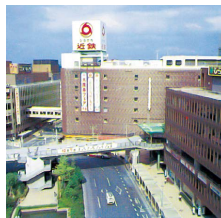
駅前広場と商業・業務ビルを整備
