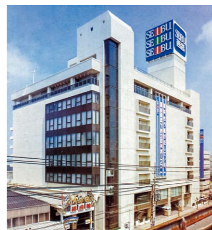
火災による消失地区の再開発事業による復興
