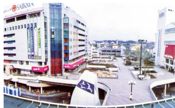
駅前広場として1階の交通広場と2階のペデストリアンデッキを整備 藤沢駅北口 【藤沢市 2.0ha】(S54.7完了)
