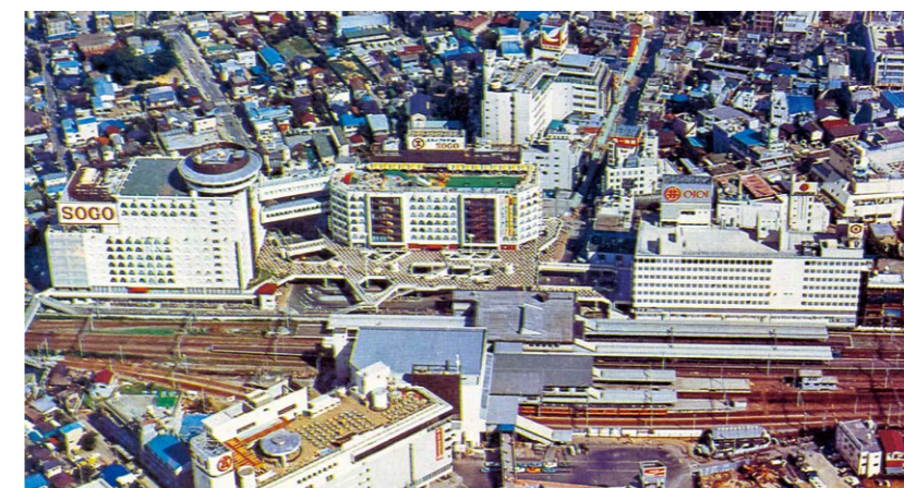
人工地盤を導入した駅前再開発事業
