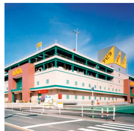
区画整理と合併施行 施設建築物は全て保留床として土地権利変換 蒲郡駅南都市軸西 【蒲郡市 2.0ha】(H12.11完了)
