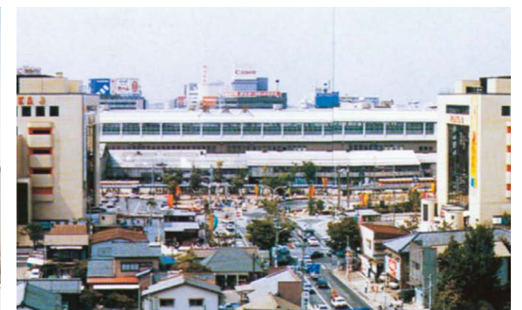
新幹線開通を契機とした 南口エリア開発の先発事業 新潟駅南口第一 【新潟市 2.4ha】(S60.4完了)
