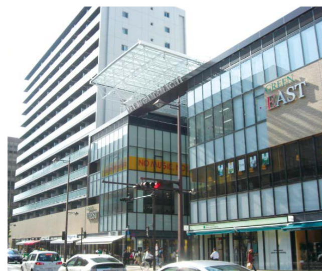
G街区西棟（マンション）
