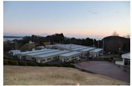
宿泊施設横の仮設住宅
