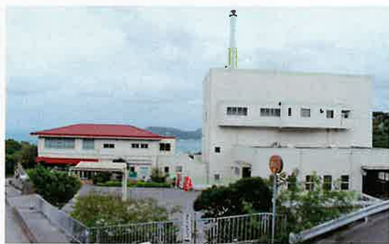
八重瀬町に新しく清掃施設が予定されるため東部環境美化センター(旧東部清掃)跡地の利用が問われる
