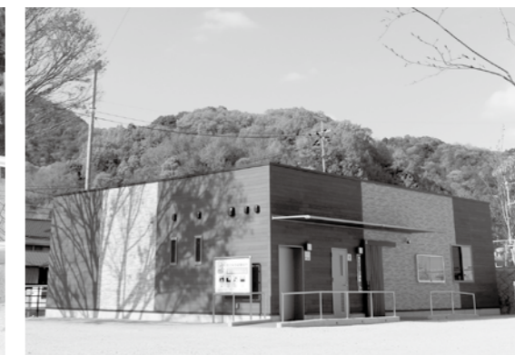
▲坂町災害伝承ホールの整備
