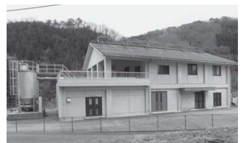
上田所浄水場
