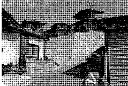
古町新住宅団地
