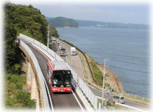
JR 気仙沼線（BRT 専用軌道部分）
