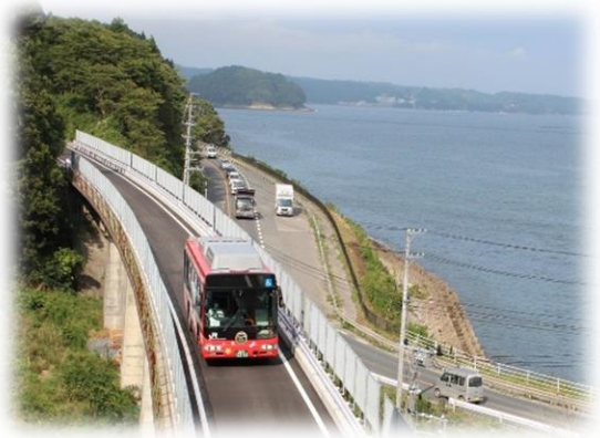
JR 気仙沼線（BRT 専用軌道部分）
