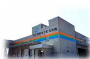
卸売市場施設復興事業 (平成28年6月完成)
