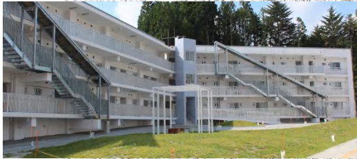
町営入谷復興住宅
