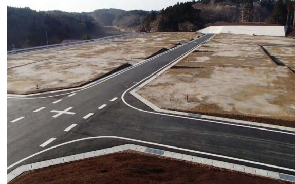
住宅建設が進む『寄木・葦の浜団地』
