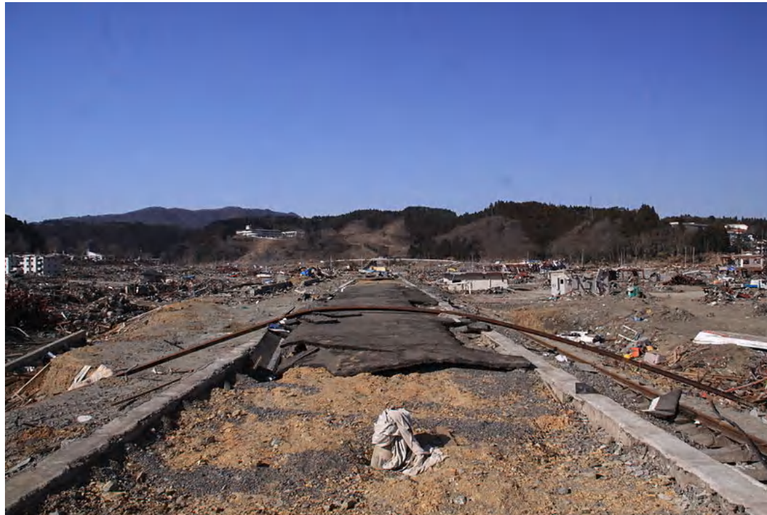
志津川駅のプラットフォーム上を横切るのは津波に捻じ曲げられたレール。
