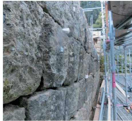
写真1 積み直しを行っている石垣
