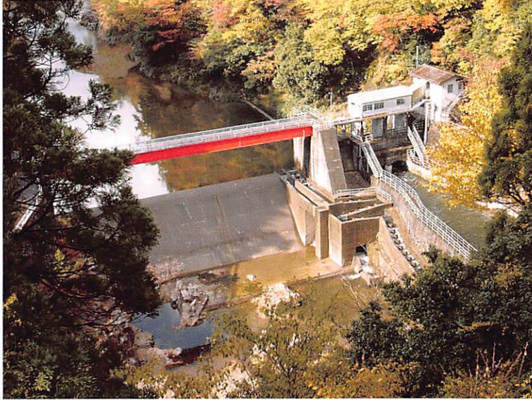
写真1 榎の平堰堤の新設魚道
