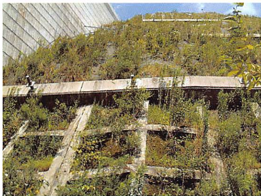
試験植栽近接写真(温井ダム左岸) (平成14年8月7日)
