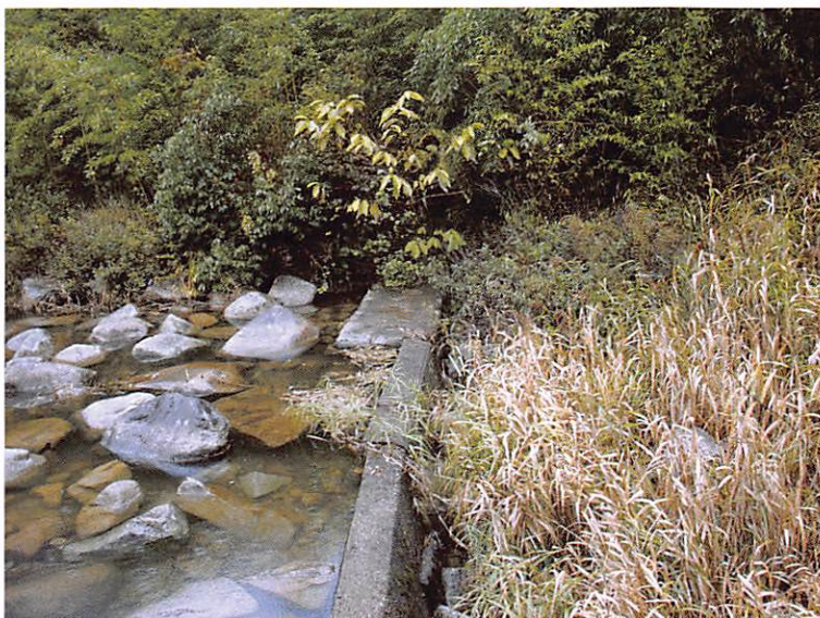
写真3 封鎖された魚道上流端
