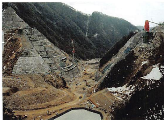
掘削完了間近（平成6年2月）
