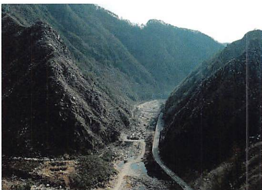
掘削前のダム地点（平成3年8月）
