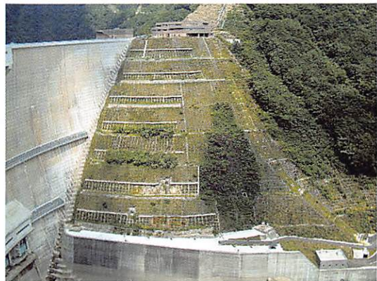
試験植栽(温井ダム左岸) (平成14年8月7日)
