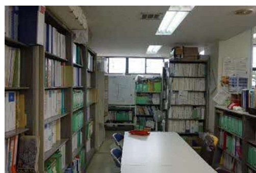
▲耐震処置未対応の収納棚類【本庁舎】
