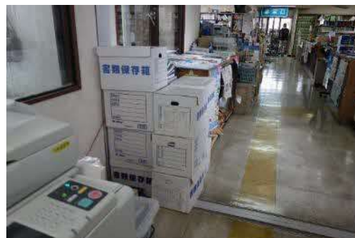
▲廊下に置かれたコピー機や書類箱【本庁舎】
