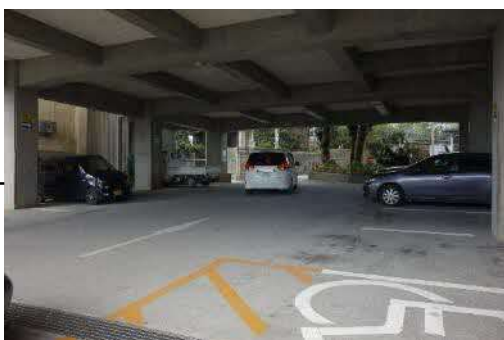
▲本庁舎議会棟下の来庁者駐車場
