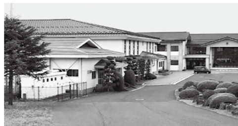
屋根葺き替え工事の終わった平泉中学校体育館
