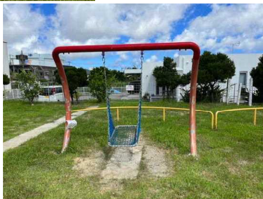
▲公園遊具の修繕作業状況
