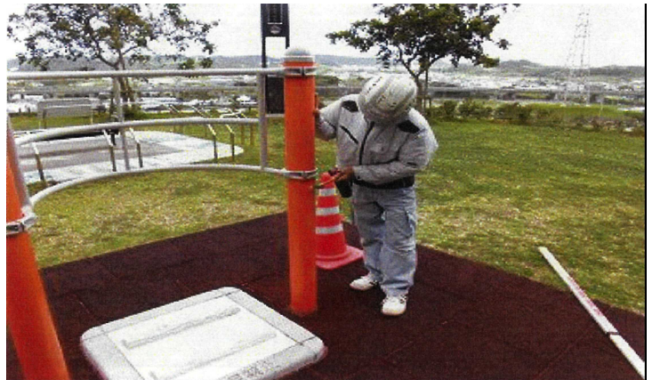
▲点検状況(遊具)
