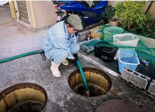
↑アパートの合併浄化槽を清掃しています
